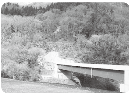
19号桜沢バイパス橋梁とトンネル坑口予定地付近
