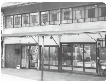
木曽平沢の空き店舗改修
