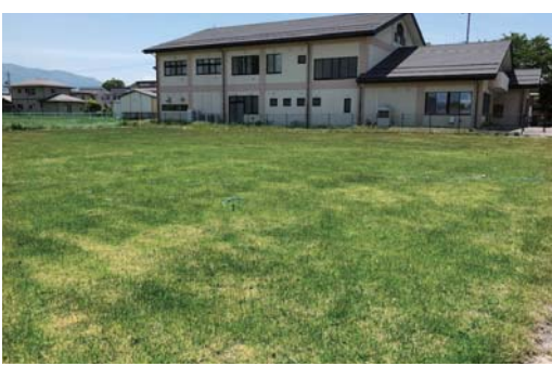
広場北側から地区センターを望む
