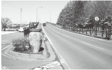
平出遺跡跨線橋
