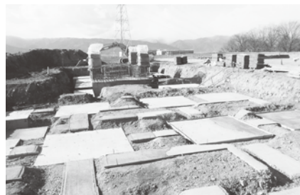
Fパワープロジェクト発電所建設着工
