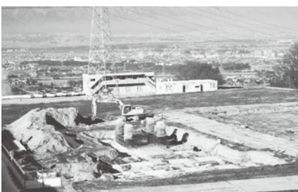
片丘に木質バイオマス発電所いよいよ着工
