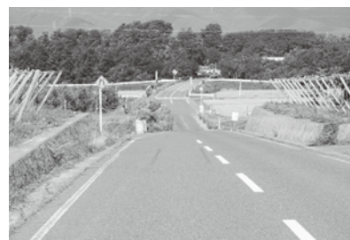
堅石今井線の狭隘部分
