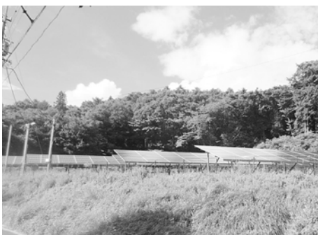
設置されている太陽光設備
