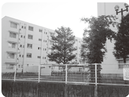
雇用促進住宅（みどりが丘住宅）
