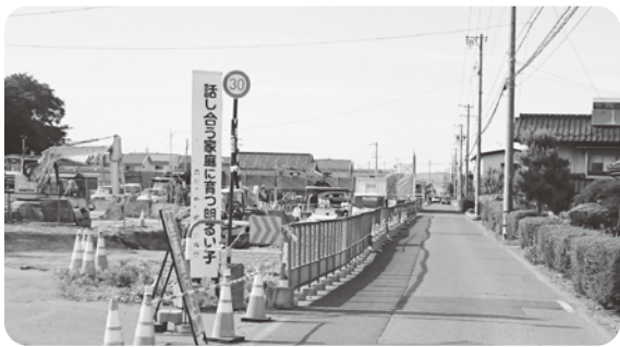
東通線 高出地区着工
