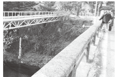
カメラを設置し水位を自動送信する琵琶橋
