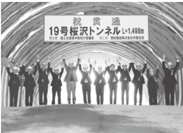
12月15日 19号桜沢トンネル貫通式
