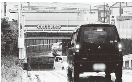
冠水したJRガード下の市道
