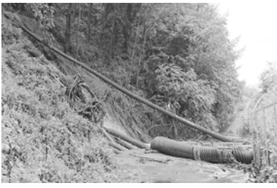
大雨災害の土砂崩れ現場
