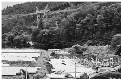
設置が進む太陽光発電パネル (8月)
