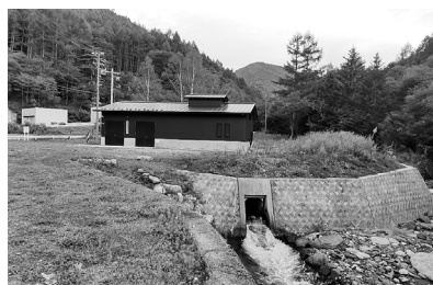
昨年稼働した奈良井萱ヶ平小水力発電所
