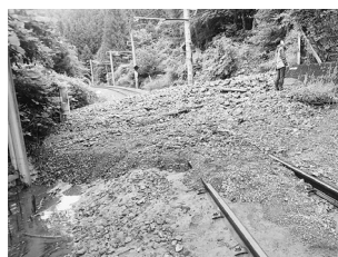
榑川長瀬のくずれ沢、鉄路に土砂が押し出した。
