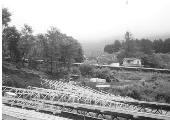
太陽光発電設備付近での土砂崩落
