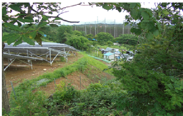
市内にある太陽光発電施設
