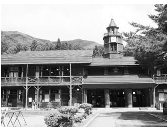
義務教育学校への改修を待つ木曾檜川小学校
