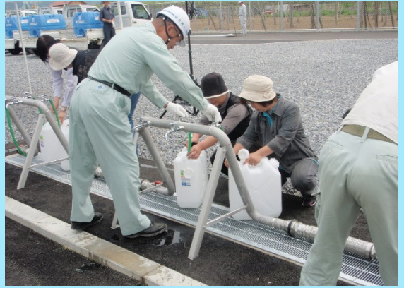
▲緊急時、配水池から各家庭への給水を止め、応急施設へ配水し、蛇口給水を行います。
