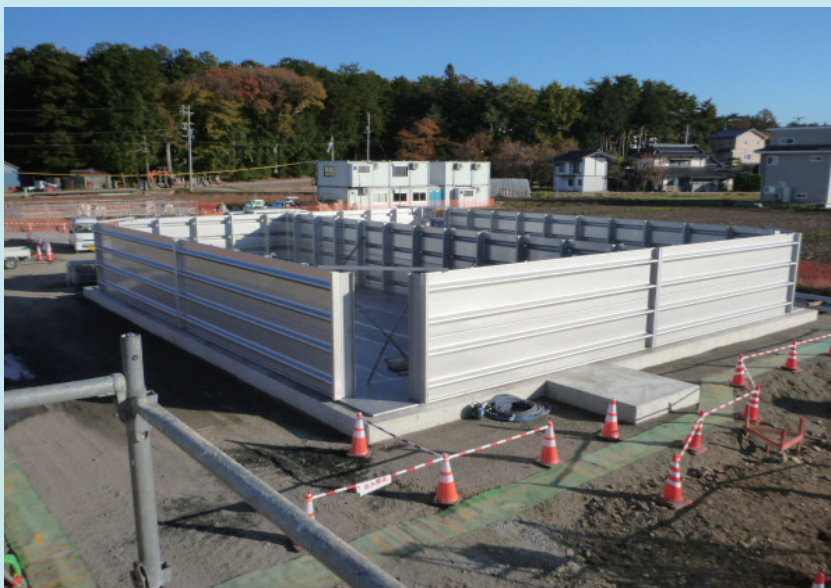
◇建設中のステンレス配水池
