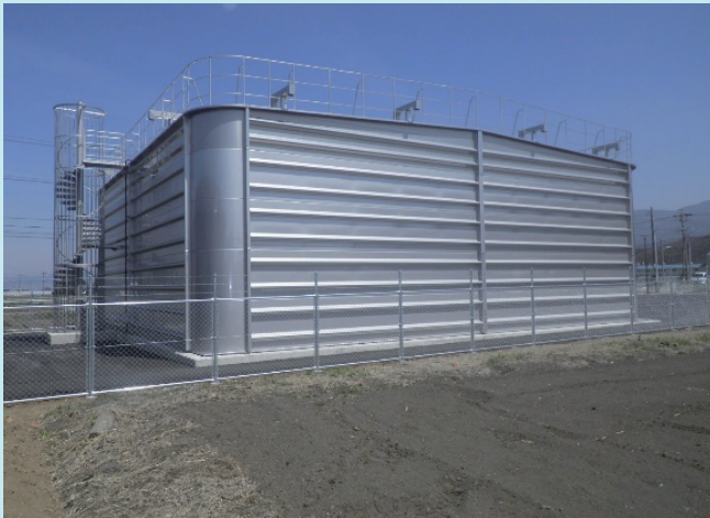
◇新しく完成したステンレス製配水池（左）と管理棟（右）
