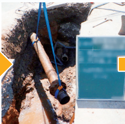
②古くなった水道管を撤去します
