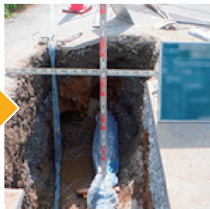
③新しい水道管に布設替えします
