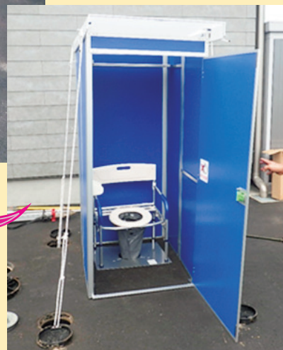
(↑) マンホールトイレ設置時
