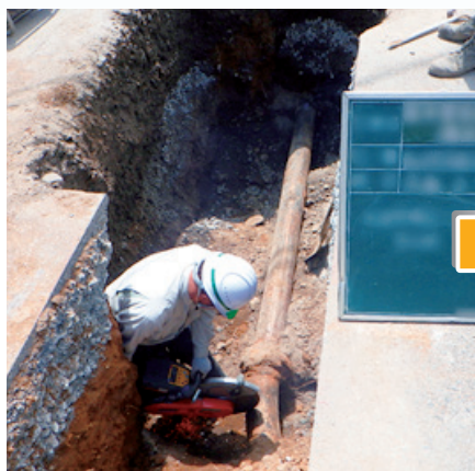
①古くなった水道管を掘り出し、切断します
