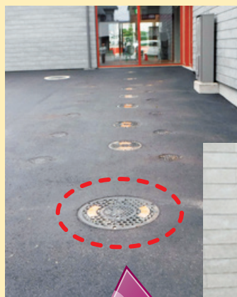
(⇔) えんてらすの 災害用マンホールトイレ
