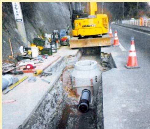
農業集落排水から公共下水道への管路を布設する工事(令和元年度施工)
