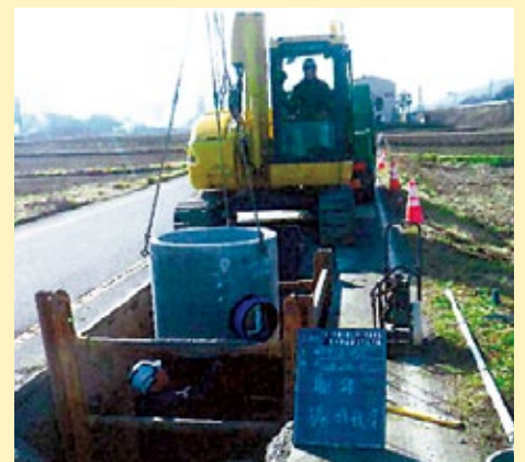
農業集落排水から公共下水道への管路を布設する工事(令和元年度施工)
