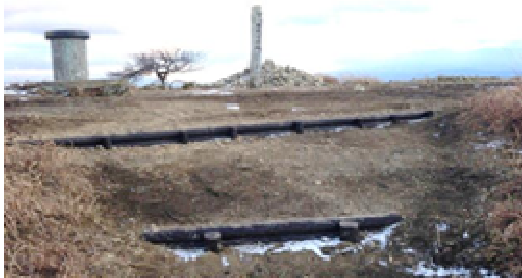
高ボッチ山頂付近の 階段整備状況
