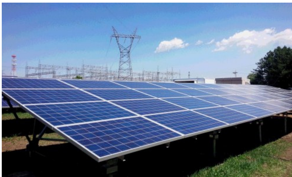
最終処分場跡地に設置された太陽光発電設備（朝日村小野沢）
