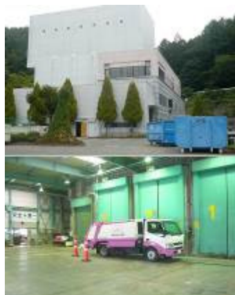
塩尻クリーンセンター (中継施設)
