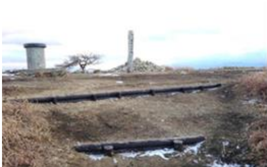
高ボッチ山頂付近の 階段整備状況
