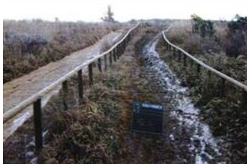
高ボッチ山頂に至る遠路の 木柵整備・裸地化対策状況
